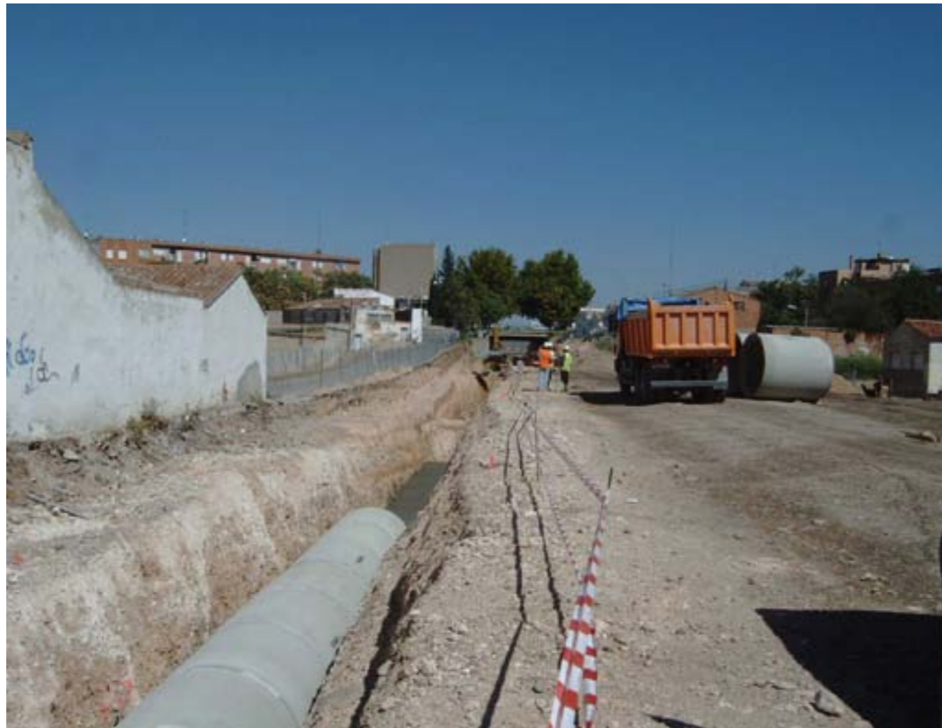
Trabajos de ejecución del Corredor Verde
