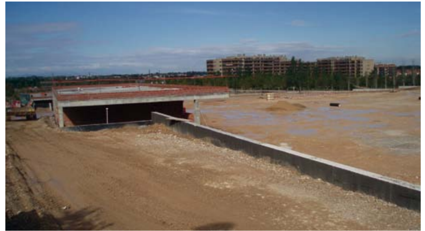
Avance de los trabajos del nuevo complejo deportivo
