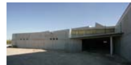
Obras Pabellón Valdefierro y Piscinas Valdefierro
