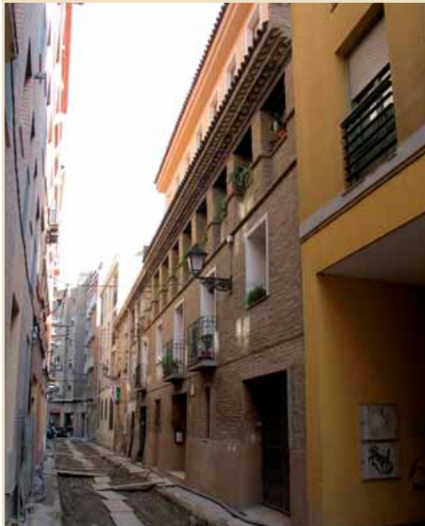
Adición de alturas
