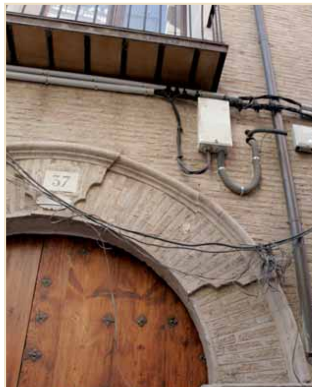
Cableados / Foto: F. Bernad, D. Marcos
