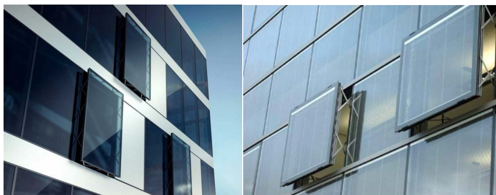
Esquema explicativo del sistema de apertura proyectante paralela propuesta, e imagen del sistema.
