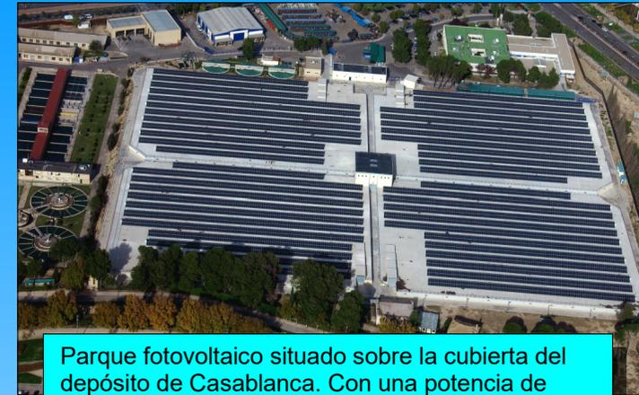
Parque fotovoltaico situado sobre la cubierta del depósito de Casablanca. Con una potencia de 2Mw y capaz de generar aproximadamente el 62% de la energía consumida en la ETAP, supone una mejora de la eficiencia energética.
