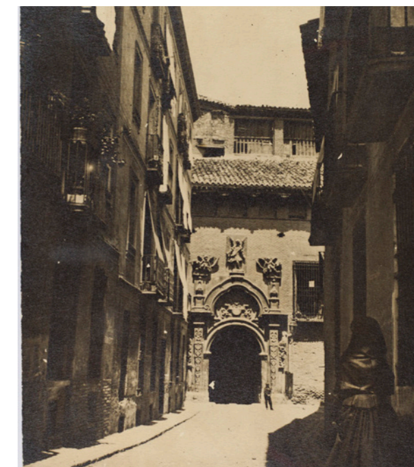
Palacio de los Salavert en las inmediaciones de la calle Santo Dominguito de Val. Imagen del Archivo Municipal.
