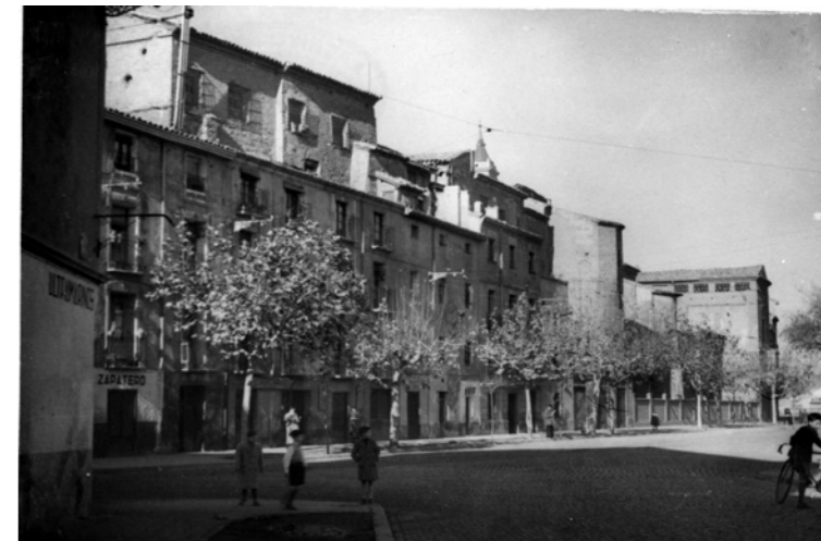
Aspecto de la muralla de piedra a la altura del Coso bajo (1878). Foto del Archivo Municipal.
