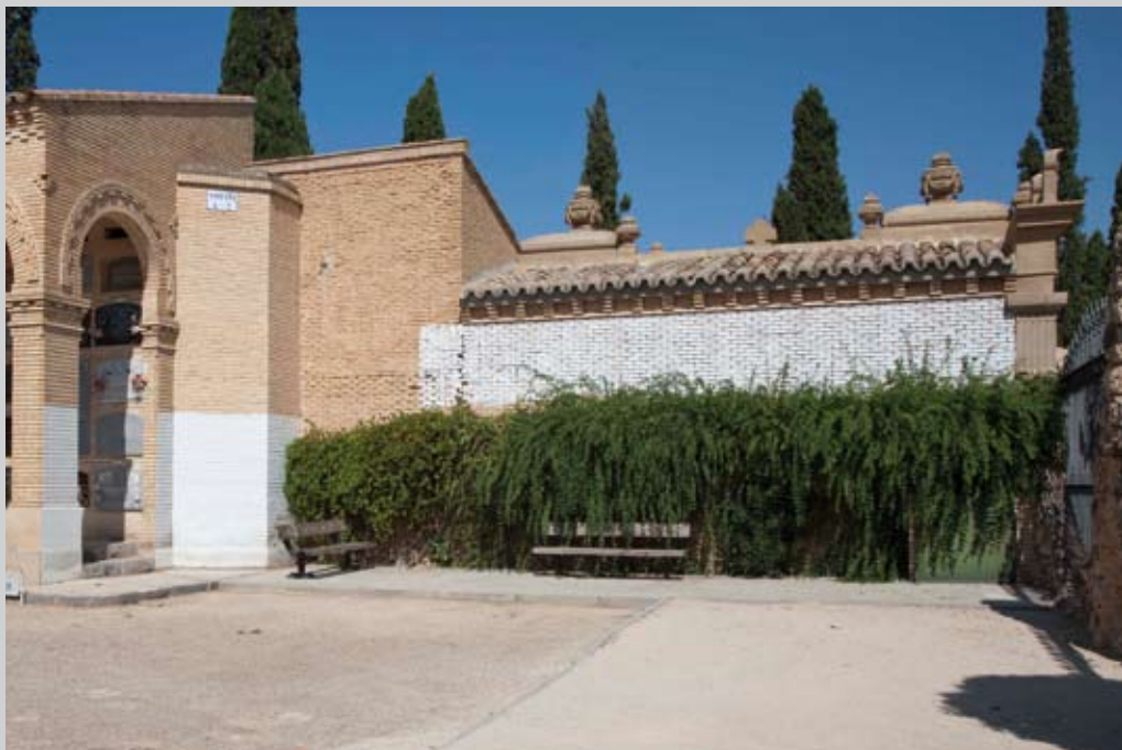
Lugar de ejecución (tapia trasera del Cementerio en 1936)
